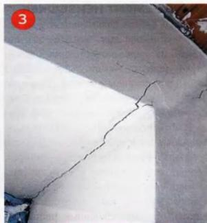
Эти трещины затронули не только штукатурный слой, но и кладку стены.
