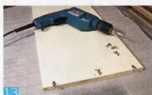
Нижняя полка будет стоять на шкантах и уголках, притягивающих полку к стойке. Подставку для бутылок и столешницу крепил с помощью эксцентриковых стяжек. А внутреннюю полку поставил на полкодержатели. Под фурнитуру разметил и просверлил отверстия.
