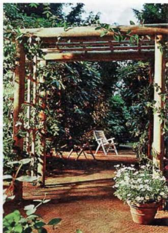
Наружный карниз перголы образуют сдвоенные поперечины со стойками. Между несущими рамами закреплены шпалеры из более тонкого кругляка под выходящие растения.
