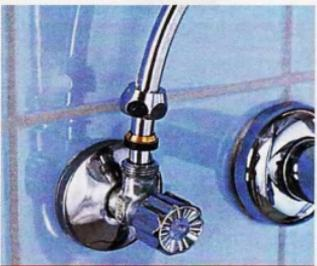
Заменяя уплотнительную прокладку стяжного кольца, подводку снова вставляют в угловой вентиль и затягивают накидную гайку. Для пробы угловой вентиль следует покрынуть туда и обратно примерно на один оборот. Если вентиль вращается трудно, желательно его заменить.
