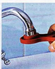
С помощью специального ключа снимают сеточную насадку излива. Промыв и прочистив её сетки, устанавливают насадку на место.
