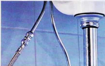
Шлифованное обжимное кольцо конической формы через тонкую шайбу плотно сжимает резиновую уплотнительную прокладку. Для этого надо затянуть накидную гайку.
