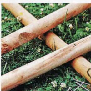
В более тонком кругляке для шпалер вырез делают на 1/3 толщины, а детали затем плотно стягивают шурупами.
