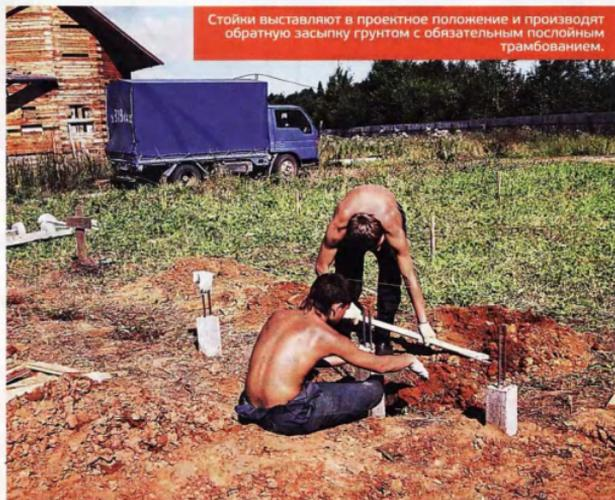
Стойки выставляют в проектное положение и производят обратную засыпку грунтом с обязательным трамбованием.
