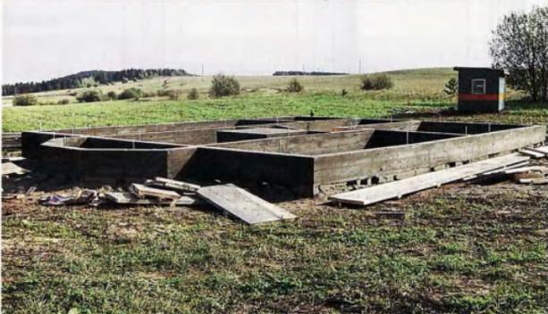
нолитный ростверк, для чего устраивают опалубку. Ширина поперечного сечения ростверка определяется толщиной стены строения, а высоту принимают в пределах 15–60 см в зависимости от шага стоек и жёсткости стен здания.
