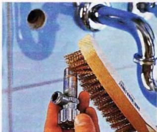
Отвернув накидную гайку и осторожно выгнав угловой вентиль, отделяют от выходящего из стены соединительного патрубка и латунной щетки очищают резьбу.
