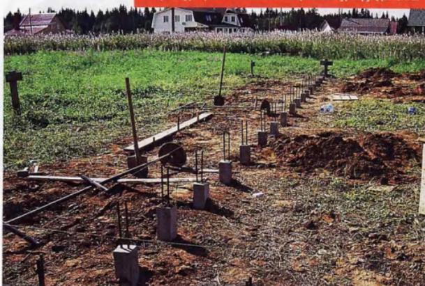
ПРИ ИСПОЛЬЗОВАНИИ ЯМБУРА ГРУНТ ВЫНИМАЮТ, НЕ ДОХОДА ДО ПРОЕКТИВНОЙ ОТМЕТКИ. ДОБУРИВАЮТ СКВАЖИНУ ВРУЧНУЮ, ЧТОБЫ СОХРАНИТЬ ПРИРОДНУЮ СТРУКТУРУ ОСНОВАНИЯ.
