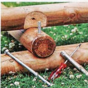
Обрезанная до нужной длины шпилька связывает обе поперечные балки со стойкой.
