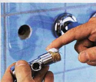
На обмотанную льном резьбу тонким слоем наносят уплотнительную пасту. Можно нанести её на резьбу и до намотки льна.
