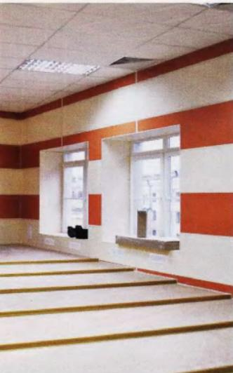
Подводя итог, нужно сказать, что СМЛ имеет как преимущества в сравнении с другими листовыми материалами (ГВЛ, ГКЛ и др.), так и недостатки. Несомненное достоинство — быстрота возведения перегородок из СМЛ, их небольшой вес, гибкость, простота монтажа, экологичность, минимум строительных отходов при
